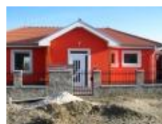
Stavebné povolenie - novostavba
